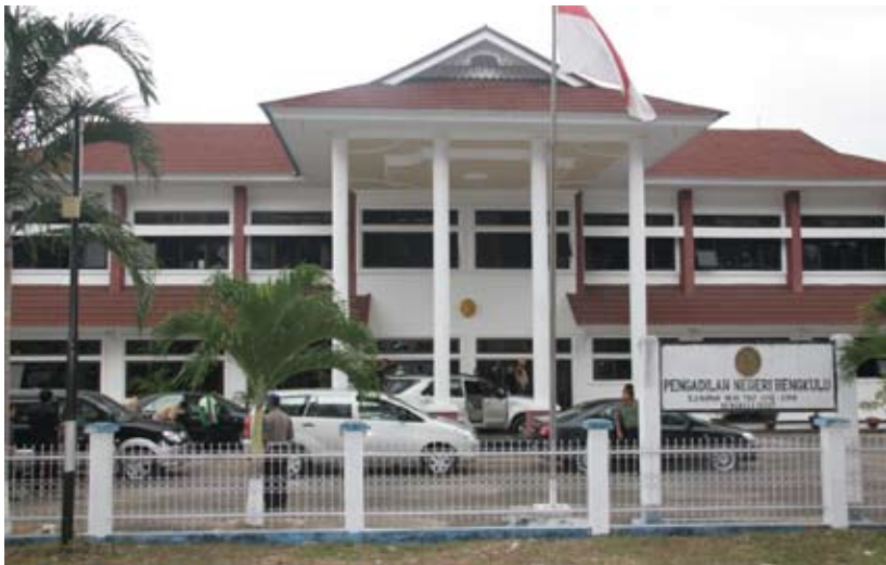
Tampak Depan Gedung Pengadilan Negeri Bengkulu
