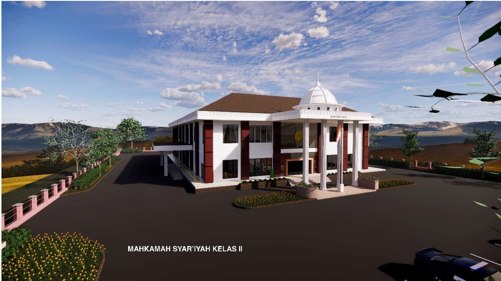
Pedoman Standarisasi Tata Ruang, Sarana dan Prasarana, Prototipe Gedung Kantor Pengadilan
