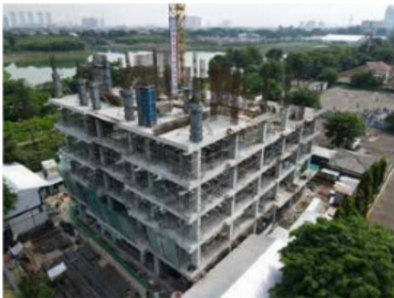
Gambar Pembangunan Rusun MA
